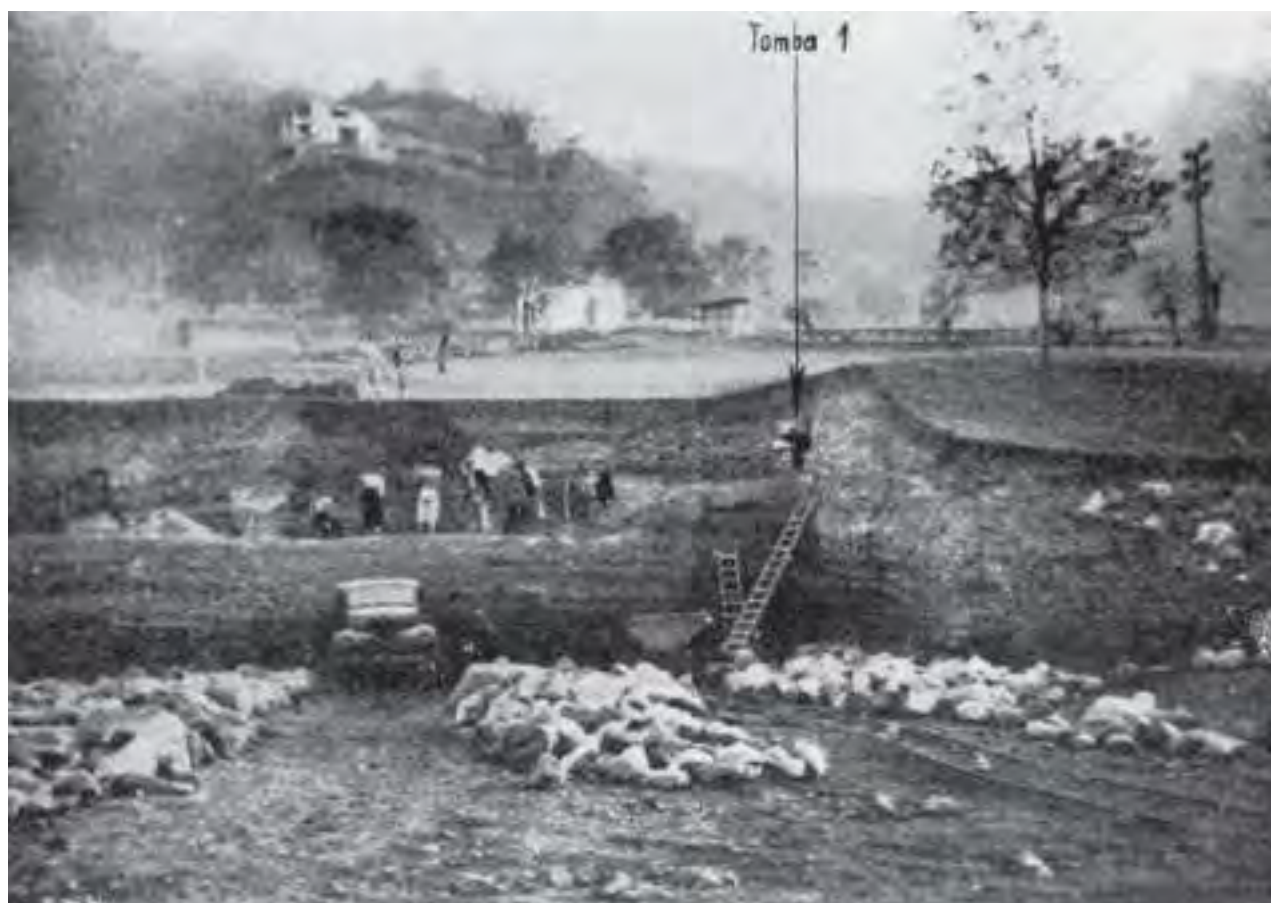
L'area del ritrovamento delle tombe nel corso dei lavori.
